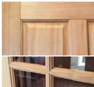
框やパネルの召し合わせ部分の溝加工により、木の収縮や膨張の変化を緩和させています。
